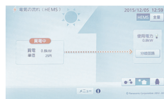
太陽光発電システムは10.5kW。 全量買取制度を利用している。
